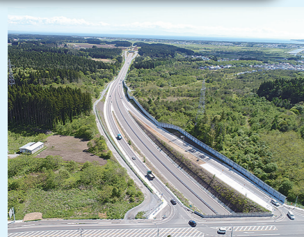
下北半島縦貫道路むつ南バイパス(むつ市)
