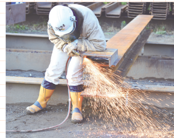
溶接技術を用いた鋼矢板の補修、 部材製作などの鍛冶仕事もこなす
