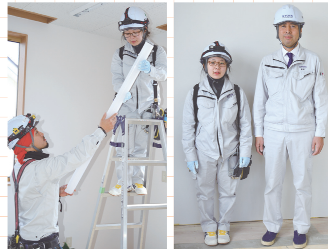
【写真左】先輩工事士の藤田さん（左）に教わりながら、2階の照明器具60台を取り付けた下川さん【同右】高橋社長（右）と下川さん
