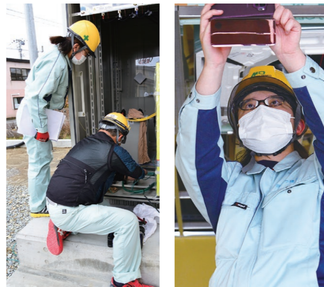
【写真左】キュービクル内の電線接続作業を確認する石田さん(左) 【写真右】天井を取り付ける前に、完成した電気設備の写真をスマートフォンで撮影する石田さん
